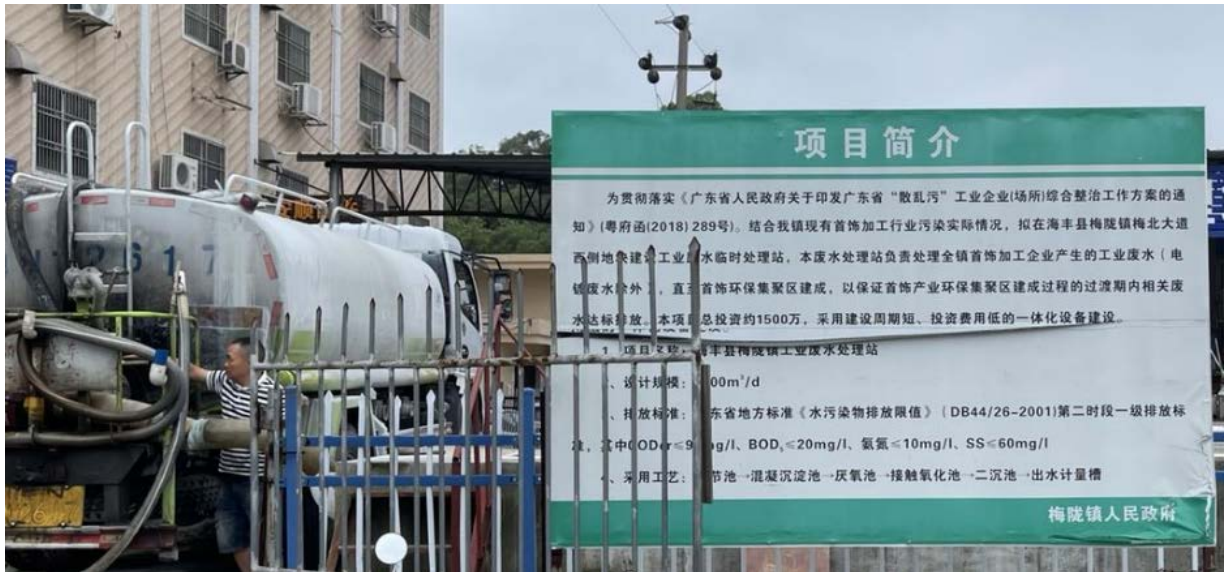
图 3.2-3 梅陇镇工业废水处理站
